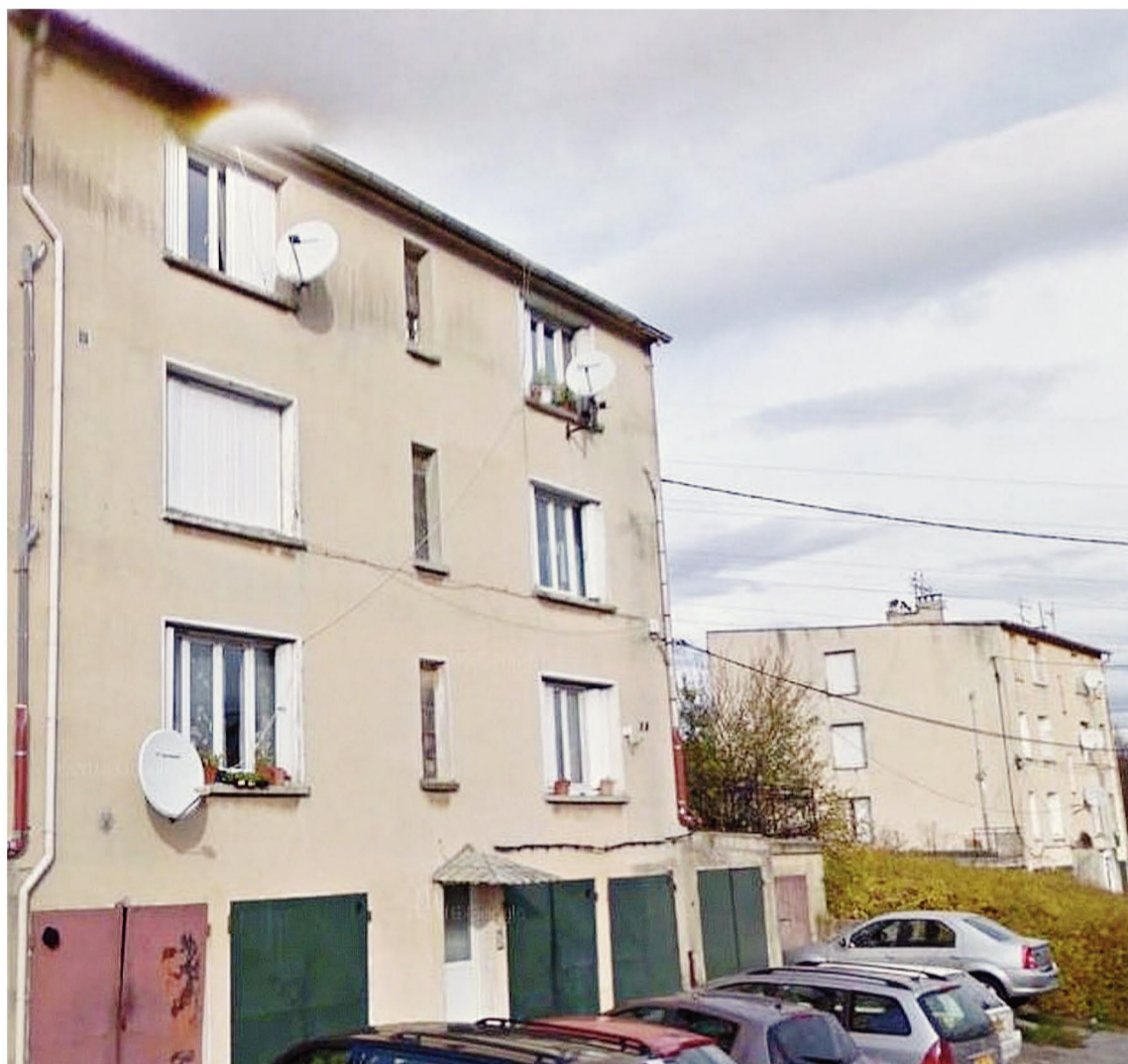
Les immeubles actuels étaient dans un état préoccupant. Ils seront détruits pour laisser place à un programme de 64 logements. CAPTURE STREETVIEW
