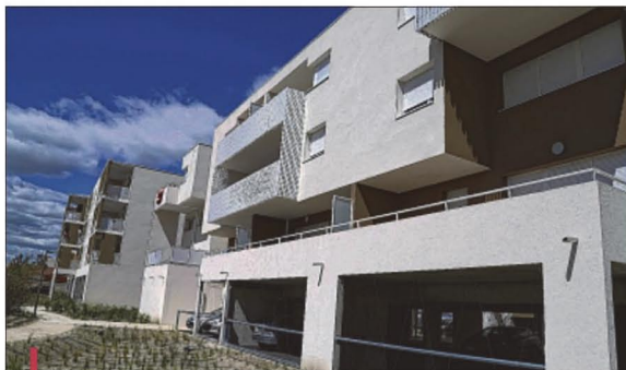
En zone nord d'Arles, en 2003, à la place de la résidence du Clos du cantonnier (▲ inaugurée en avril 2016), il y avait 1,50 m, 1,70m d'eau. Cette résidence est une sorte de modèle de l'urbanisation en zone inondable, l'ensemble des bâtiments étant surélevé de deux bons mètres.
